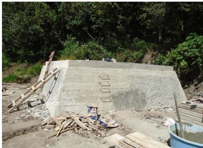
Foto: Tanque de almacenamiento de agua, en construcción.
