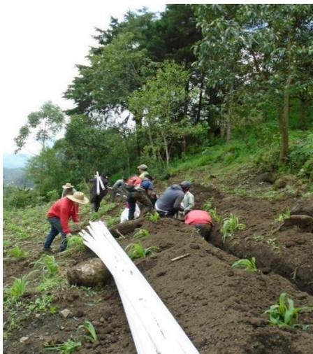
Foto: Colocación de tubería PVC, en línea de distribución.
