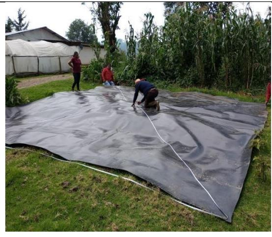
**Figura 20:** Construcción de Cosechadores de agua con fines de producción Agrícola.
