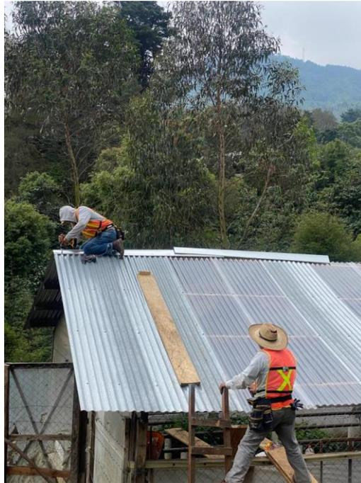
**Fotografía 15:** Colocación de las laminas nuevas
