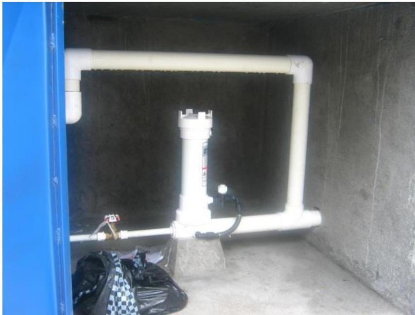
Foto: Revisión de thermocloradores en proyectos de agua.
