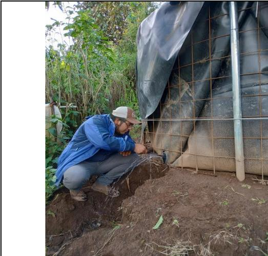
**Figura 22:** Instalación de salida de agua de cosechador para implementación de riego.
