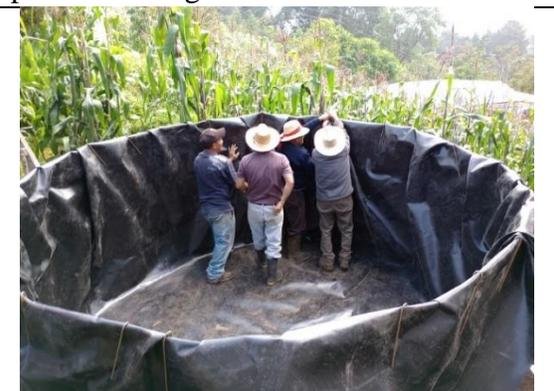
**Figura 22:** Construcción de Cosechadores de agua con fines de producción Agrícola.
