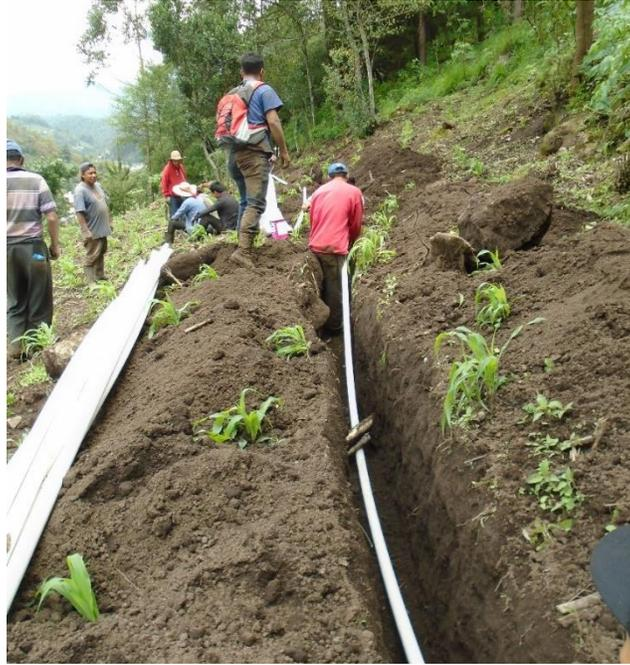
Foto: Instalación de tubería en línea de distribución de agua
