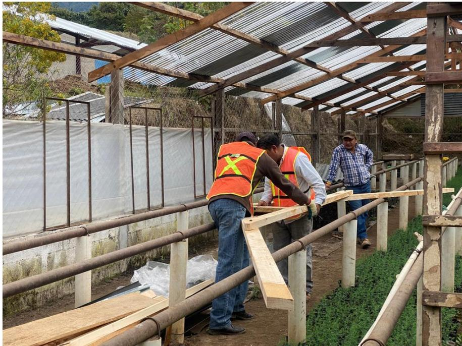
**Fotografía 13:** Construcción de nuevas tijeras para realizar el cambio de las tijeras dañadas del vivero forestal.
